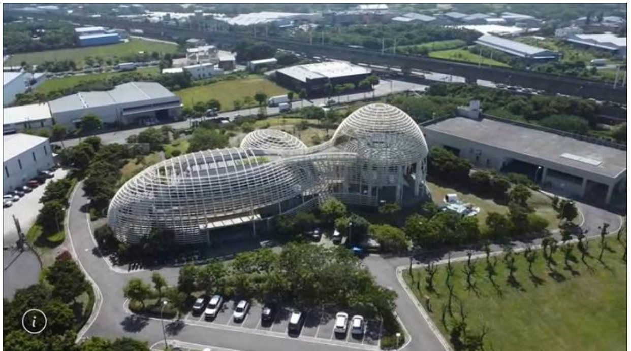
空拍圖- 日鼎水務 桃園北區水資源回收中心廠區
